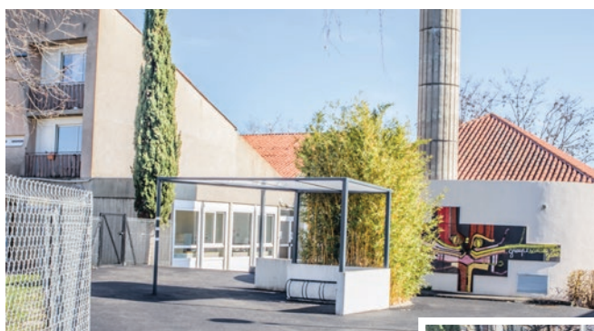
Installation d'un garage à vélo et réfection de l'enrobé
