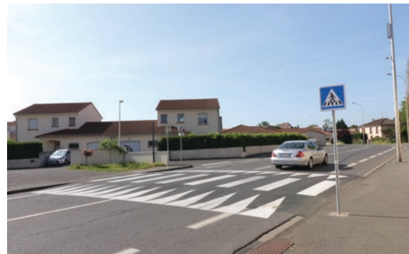
Nouveau passage piéton surélevé avant la rue du Pont.
