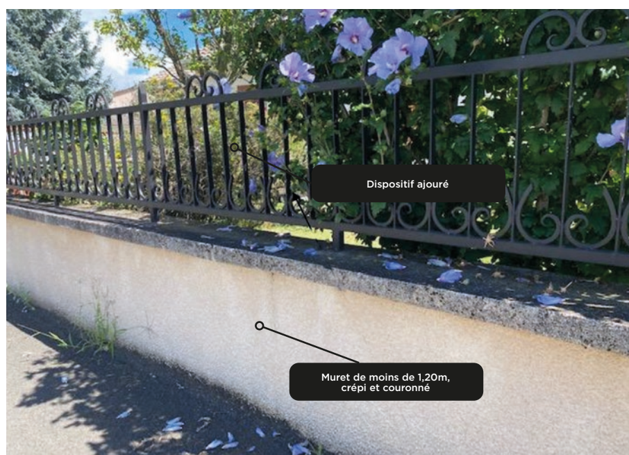
Photo illustrant un muret crépi et couronné de moins d'1 m 20, surmonté d'un dispositif ajouré, en zone non-inondable.
