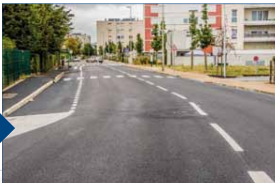
Rénovation de l'enrobé et des trottoirs de la rue sous les Ors
