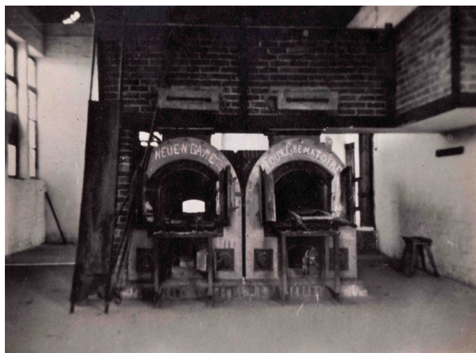
Fours crématoires du camp de Neuengamme
