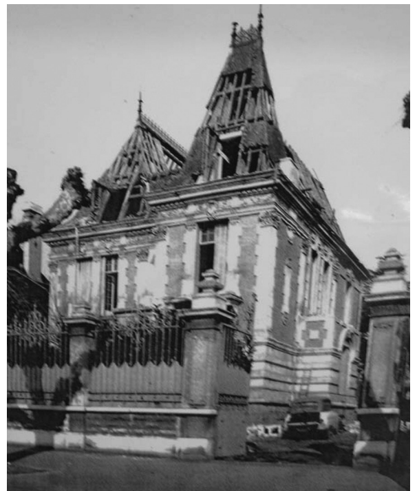
Villa du 2 avenue de Royat
