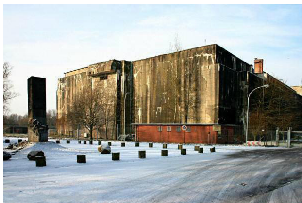
Bunker Valentin - Brême
